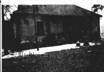
ok. Gdowa - dwór, pow. 600 m 2 , park 7 ha, zabudowania gosp., cena 360 tys. zł
