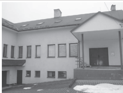
BALICKA , okolice, 834 m 2 , obiekt produkcyjno-magazynowy z częścią biurową, 1998 r., rampa, winda towarowa, możliwość rozbudowy. Działka 46 a Of 2767, 3 300 000 zł
