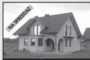
KRYSPIŃÓW – Dom wolnostojący, stan surowy, zamknięty. Cena 850 000 PLN
