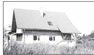
Gdów - 200 m2 - 170.000 zł, dz. 12a do wykończenia, media w domu
