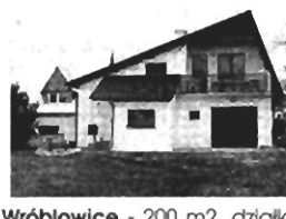
Wróblowice - 200 m 2 , działka 10,5 ar, dodatkowo budynek 70 m 2 - sklep + mieszkanie, cena 320.000 zł
