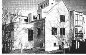
Wola Duchacka , nowy stan surowy zamknięty, solidnie zbudowany, 300 m 2 , 5 arów, 270 tys. zł, of 121/187
