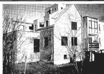
Wola Duchacka , nowy stan surowy zamknięty, solidnie zbudowany, 300 m 2 , 5 arów, 265 tys. zł
