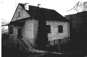
Płaszów - dom wolnostojący, parterowy po generalnym remoncie, strych do adaptacji, p.c. 170 m 2 , 8,7a. Cena 130 tys. USD
